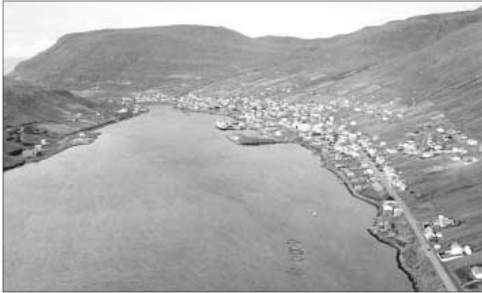
Um trý ár stendur flunkandi nýggjur miðnámsskúli fyri 50 milliónir klár at taka í nýtslu í Vági. Í skúlanum verður eisini meginbókasavn fyri alla Suðuroy og samkomuhøll
