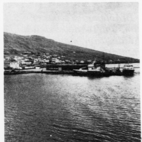
Arbeiði hevur verið á flakavirkinum í Vági at kalla hvønn dag, síðan virkið læt upp aftur
