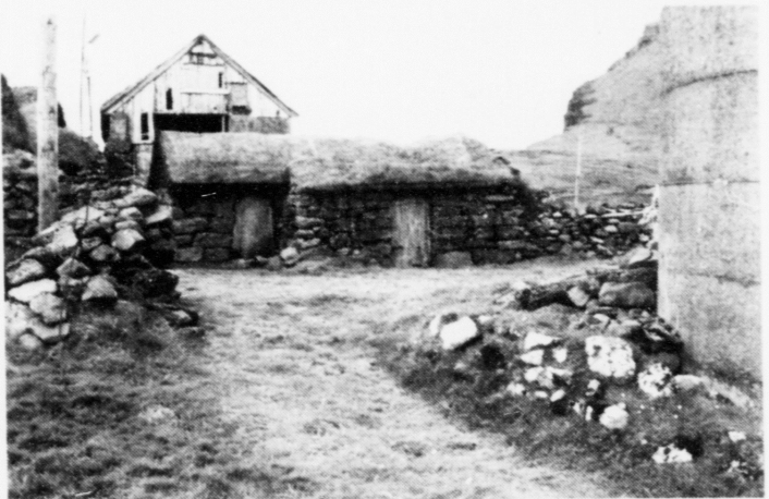
Seyðafjørður, sum eisini varð nýtt til at ripa korn í. Aftanfyrri sæst gamla bønhusið, sum er frá tíðini áðrenn trúbotina. Bønhusið er hægr enn tað hevur verið, men ætlanin er at taka tað niður, og byggja tað upp aftur í upprunaligu støddini
