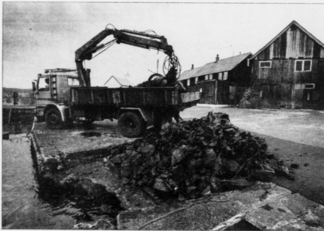
Grótið frá dýpingini verður nýtt sum ifylla, tí bryggjan skal breiðkast. Mynd Kalmar
