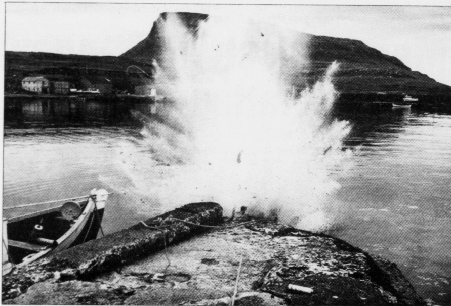
Hetta eru ikki Geysir í Nólsoy, men dynamitt sum dýpir og reinsar botnin kring gomlu bryggjuna. Mynd: Kalmar
