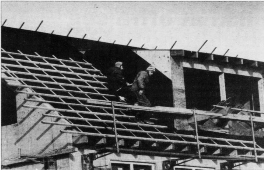
Ein óvanlig sjón í Føroyum í dag. Byggifyritøknar nýðast av landinum fyrri at fáa okkurt at gera
