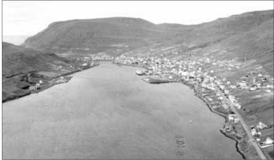
Arbeiðið upp á djúphavnina í Vági byrjar beint eftir summarfrítíðina og tað er Byggitek, sum skal gera arbeiðið
