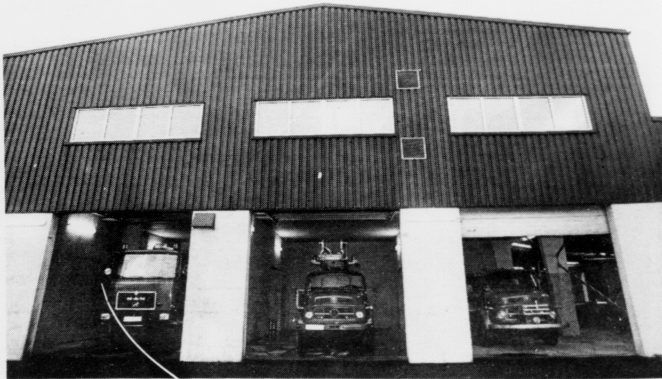
Brandstøðin í Havn hevur tíggju bílar av ymiskum slag, ein bjargingarbát og útgerð til fjóra froskmenn. Mynd: Kalmar
