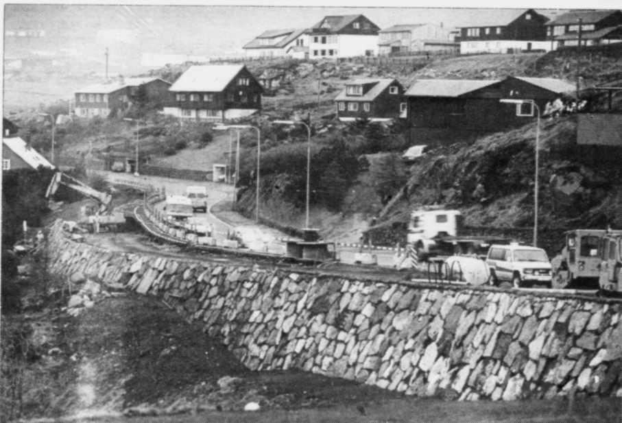
Veggerðin við Hvítanesvegin í Hoydølum hevur higartil kostað hálvatriðju millión. Arbeitt hevur verið tilsamans í eitt ár ella so, men innan fyrri eitt ár er arbeiddið liðugt Mynd: Kalmar Lindenskov
