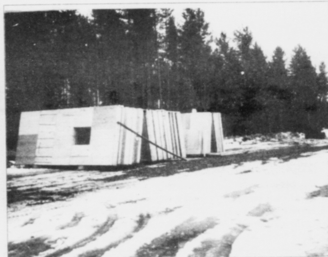
Tey fyrstu byggielementini
