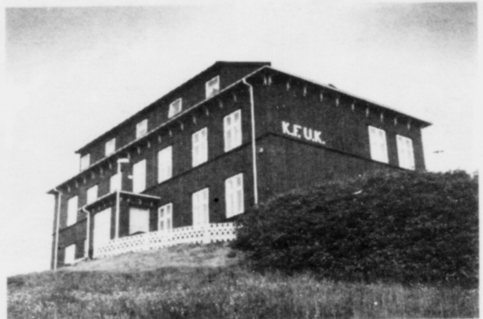
KFUK varð stovnað í 1922 sama kvöldið sum húsið varð vígt
