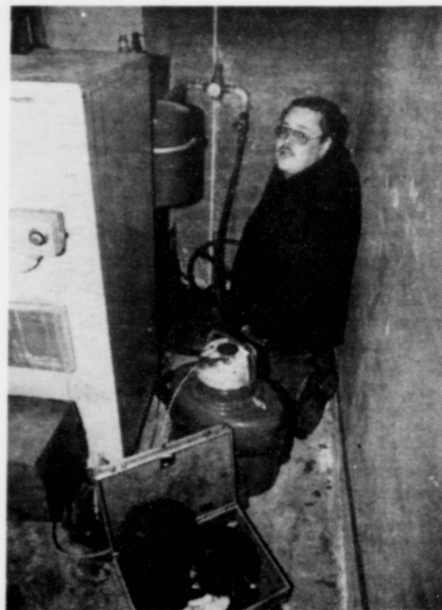
Tað er ikki neyðugt altíð at fara upp á tekjuna fyrri at reinska skorsteinin. Við eini fjøður fær Andrass kustin allan vegin upp gjøgnum kaminuna
