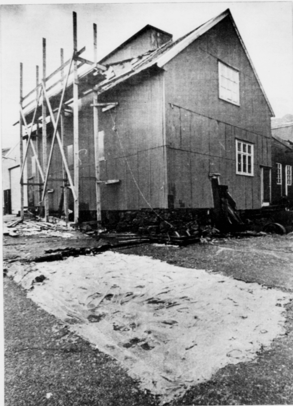
Stórur partur av asbesttekjuni er skiftur út, men bert nakrar fáar plátur eru at finna niðri í túninum. IRF hevur ikki fingið nakra asbestplátu av hesi tekju. Okkum hevur ikki borið til at fingið uppspurt hvar restin av asbesttekjuni er endað, men herfyri var eitt djúpt hol í túninum við húsinu. Nú er hett hol fyllt upp og í skundi er stoypt út yvir hetta øki sæst fremst á myndini, sum myndamaður okkara tók norðuri við Áir í gjáramorgunin. Mynd: Kalmar Lindenskov
