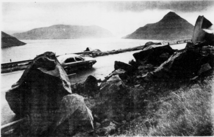
Arbeiðið at loysa og beina burtur grót úr berginum við Brúnarenda, eftir at skriðulop var herfyri, er um at verða liðugt. Myndin er tikið beint eftir skriðulopið. Teir størstu klettarnir, sum duttu út á vegin, vigaðu um 20 tons. Enn er ikki avgjørt, hvussu bergið skal tryggjast imóti, at tað leypur aftur fleri møguleikar hava verið nevndar eitt nú at spreingja alla forsiðuna av grótbrotinum burtur. (Mynd: Kalmar Lindenskov)
