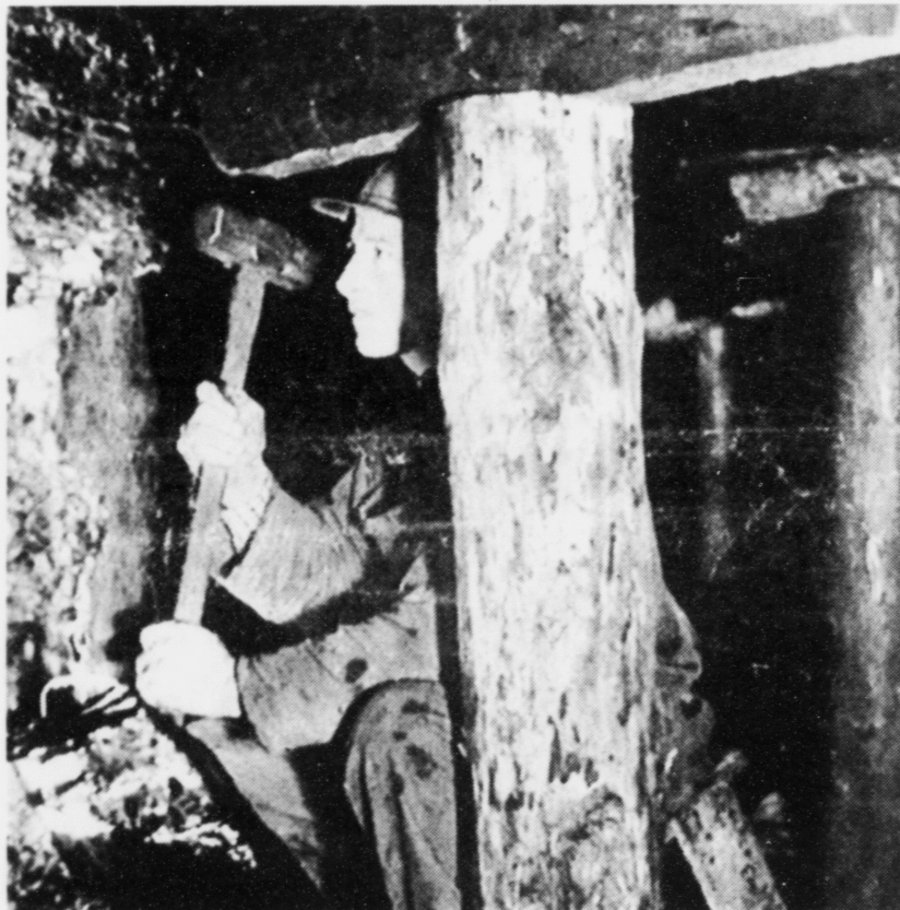
Stabbahogging. Andreas Lindberg , Andreas á Beitinum , kilar niður. Hann hevur júst sett kilan í (ovarlaga í vinstra horni á myndini) og ger seg til at sláa. Bulurin , ið stendur upp undir yvirleggjaran, nevnist stemplið, og arbeiðið at seta upp undir takið kallaðist at stempla upp. Leggdi eisini til merkis lyktina niðast í vinstra horni og kolaskammilin. Har Andreas situr, er so lágt, at ein maður ikki fær staðið upprættur. Mynd tikin í 1939.
