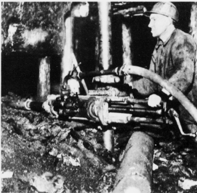
Hans Jacob Midjord arbeidir við hoggmaskinuni. Maskinin gekk við lufttrýsti og sat á eimi sálu, ið varð spent ímillum tak og golv, soleiðis at hon snarði um sáluna. Kasnið er til at vinna maskinuna fram við. Leggið merki til propsið, og hvussu lígt tað er innan fyrir mannin. Myndin tikin í 1939.
