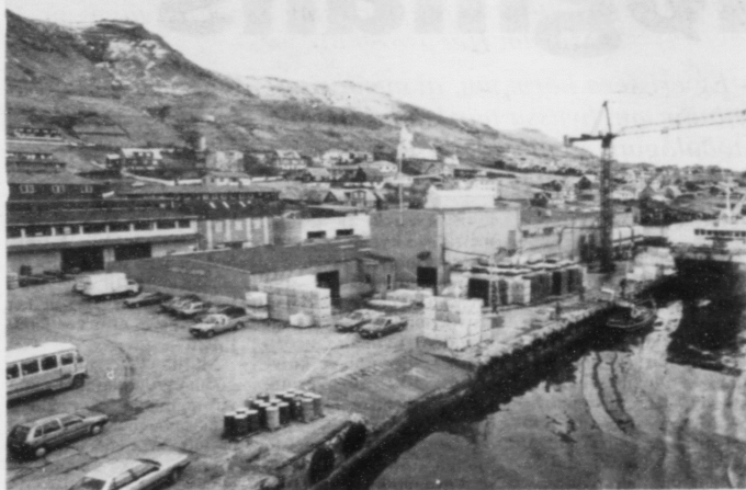
Á flakavirkinum á Tvøroyri er rættilig gongd komin á aftur. Arbeiðið hefur verið hvønn dag seinastu tíðina
