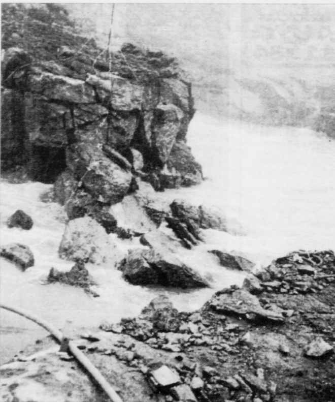
Seinasta skotið er júst loyst av, hol er komið á, og sjógvurin streymar inn í nýggja bátahylin
