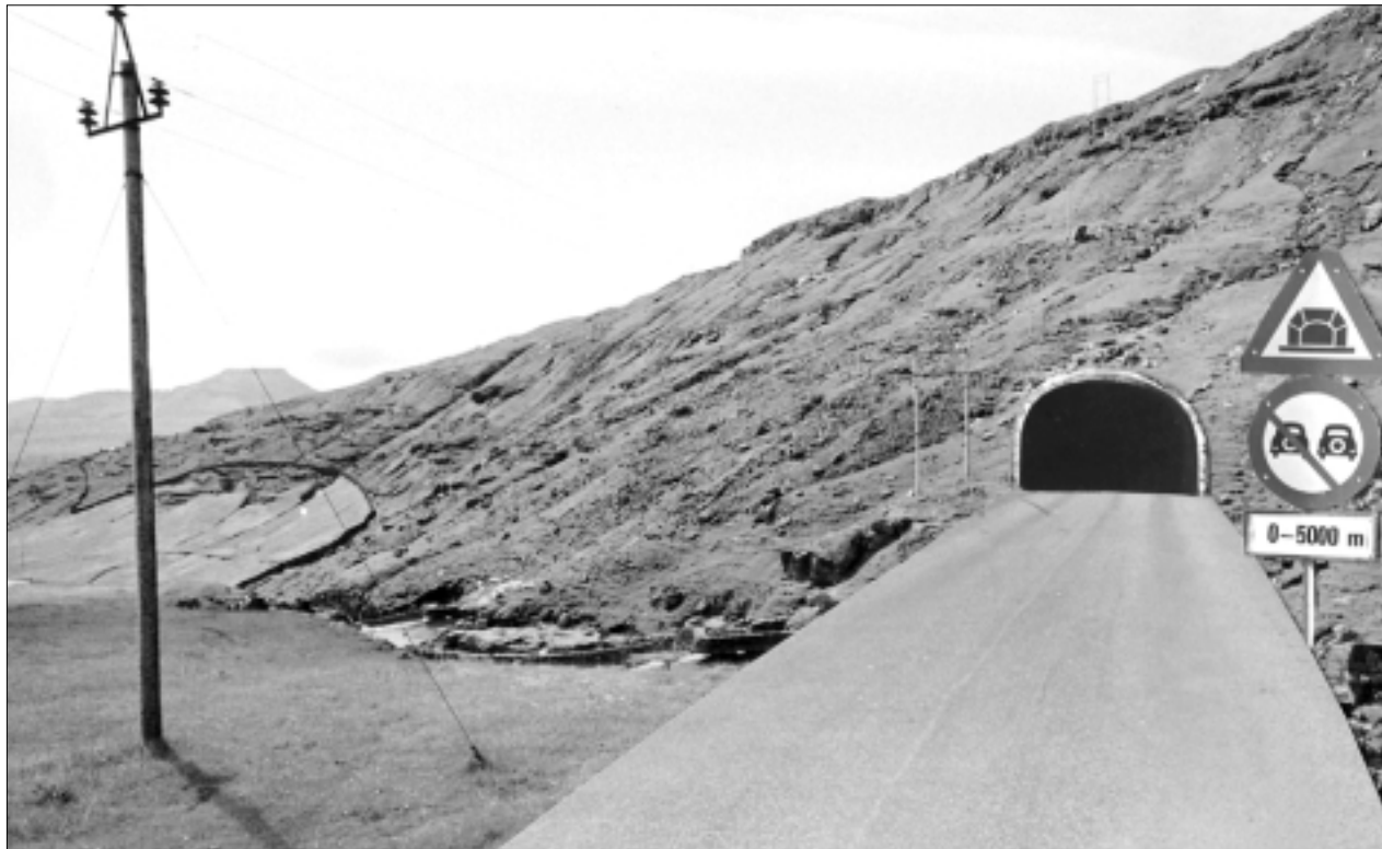
Landsverkfrøðingurin skuldi lata P/F Vágatunlinum tilmæli um, hvat tilboð var tað besta. Og hjá honum var onginn ivi um, at Byggitek skuldi fáa arbeiðið at gera vegirnar til undirsjóvartunnilin, tí teir høvdu tað lægsta tilboðið. Men hóast tað, verður nú samráðst við J&K Petersen um at gera arbeiðið
