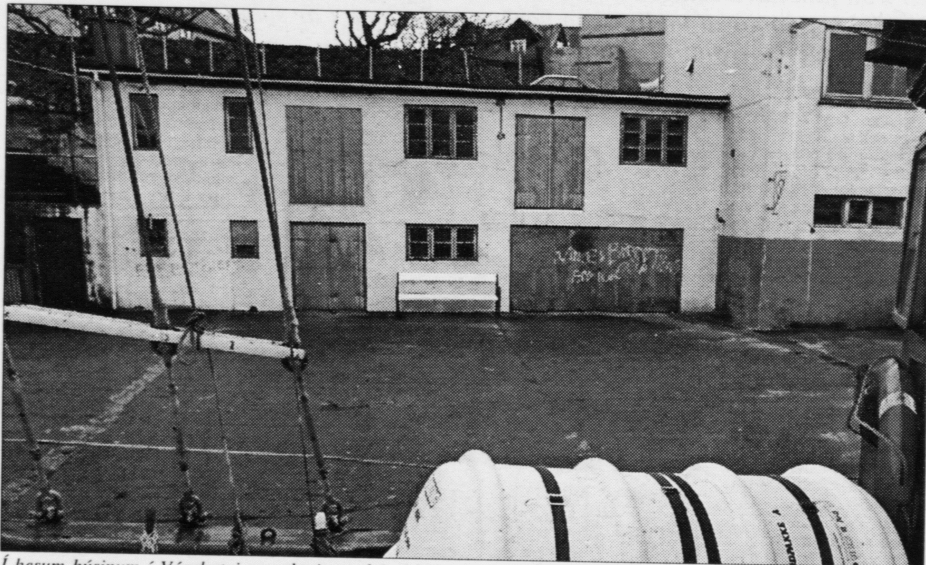
Í hesum húsinum í Vágshotni er ætlanin, at bátafelagið skal halda til, saman við bjargingarfelagnum. Húsið er í tveimum hæddum og stendur ímillum Samvinnufelagið og „saksfórarborgina“. Men nógv er at gera við tey.
