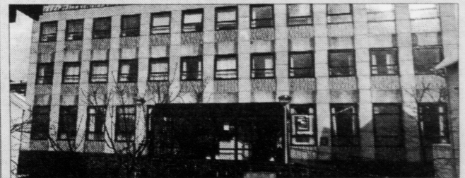
Føroysku fíggjarstovarnir hava stovnað egið arbeiðsgevarafelag
