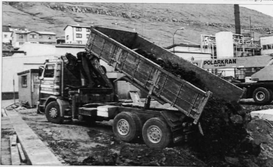
Arbeiði við at útyggja havnina niðanfyri Pelagos í Fuglafirði er nú byrjað. Pelagos hevur ætlanir um, at byggja út so teir kunnu taka móti eini triggjar ferðir meir enn tað, teir kunnu í dag
