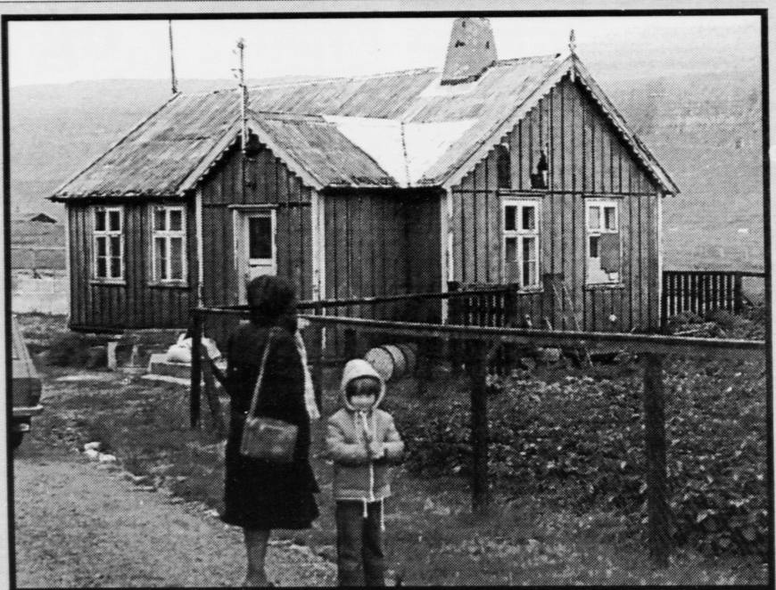
Í farnu viku brendu losjuhúsin á Sandi í grund. Losjan »Skorðatindur«, sum var stovnað 10. okt. 1930, var virkið felag. Tey fóru undir at byggja húsin í 1932 og byggimeistari var Steingrím Davidsen. Slík hús hava kostað nógvan penin, eisini tá í tíðini og tí mátti peningur útvegast. Til tað endamálið framfórdu sandingar leikin »Tann politiski kannustoyparin« - eitt satt megnartak, má sigast. Myndin omanfyri er frá 1980, og er tikin áðrenn húsinu fingið nýggja tekju og nýggjan klæðning. Sum nevnt brendu húsin í farnu viku og tey fórust so illa, at einki annað var at gera uttan at taka tey niður
