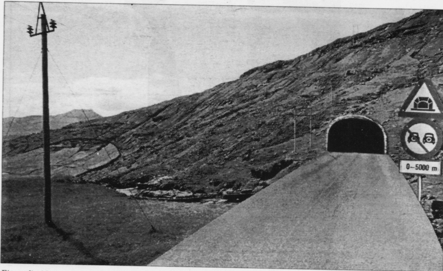
Ein undirsjóartunnill uttan bummþengar gegur besta samfélagskasti, sigur verkætlanarbólkur undir Vinnumálastýrinum
