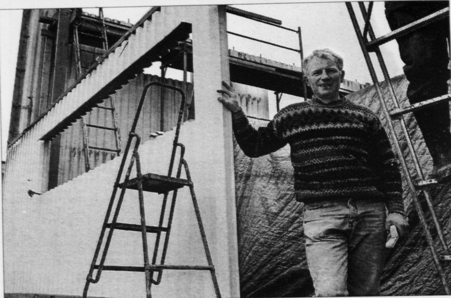
Soleiðis sær ein grund út, sum er stoypt við plastikkformum, sum verða standandi eftir at stoypiarbeiðið er liðugt. Helgi Olsen sá »systemi» í einum norskum verkfrøðingablað og hevur tikið tað til sín (Mynd: Jens Kristian Vang)
