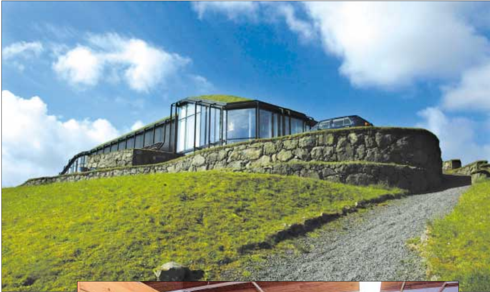
8. MAI: Norðurlandahúsið verður 20 ár. Næsta uppgávan hjá Norðurlandahúsinum verður í størri mun at fáa onnur uppi at draga línuna saman við húsinum. Hetta kundi verið vinnulívið og ymiskir grunnar, sigur Helga Hjørvar, stjóri í Norðurlandahúsinum.
