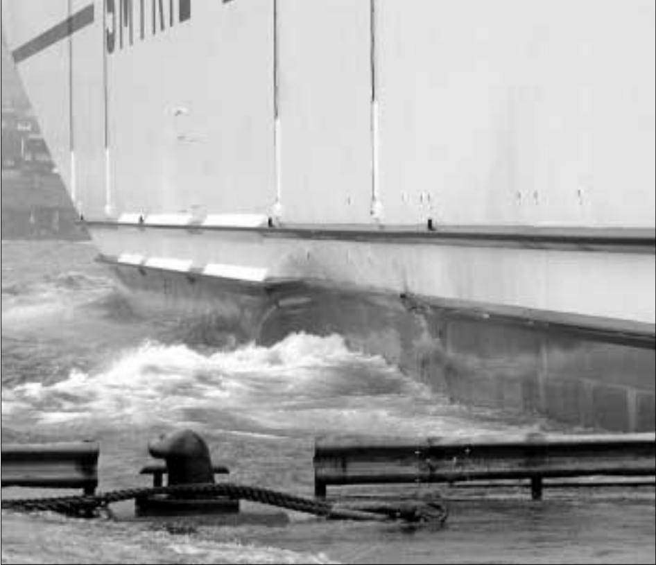
...og her sæst skaðin. Hol er undir vatnganginum og vatn lak inn í maskinrúmið
