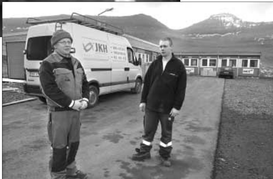
Fyrirøkan, JKH í Rytuvík, hevur havt timbarmenn í Leirvík seinastu mánaðirnar, sum hava smíðað fyri arbeiðstakararnar og byggi-harri
