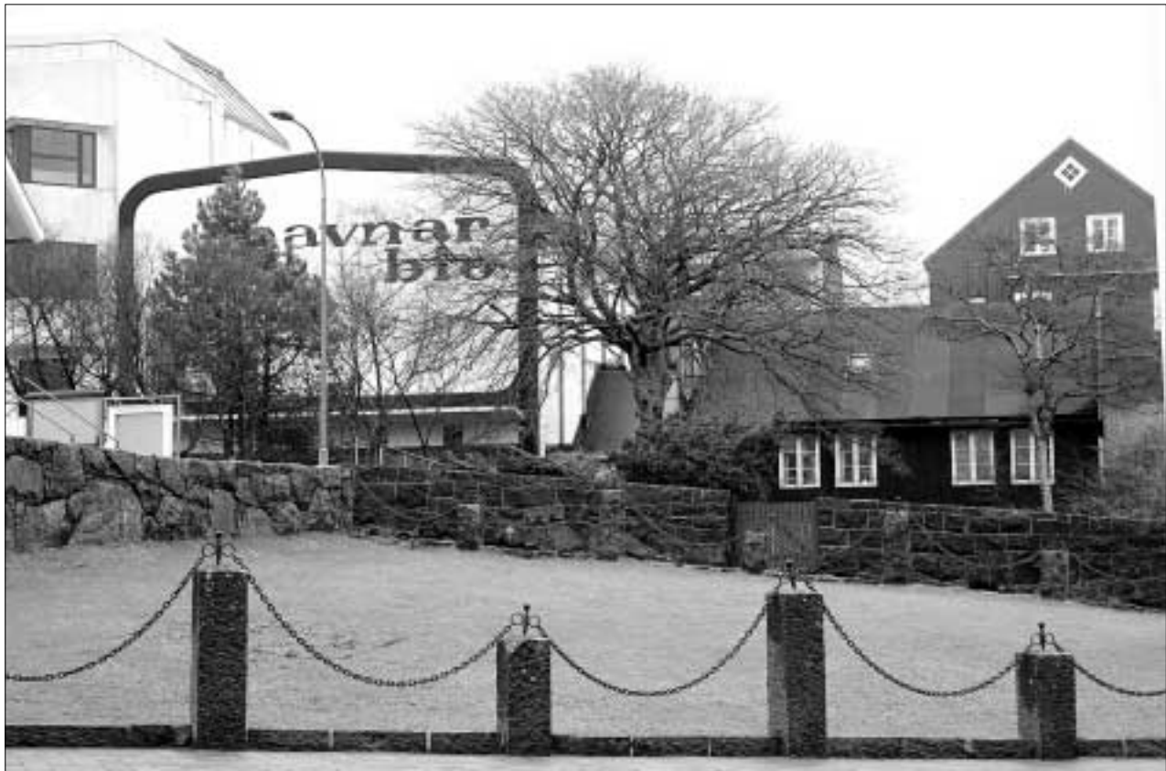
Húsini hjá Anton Degn, høggu megin á myndini, skulu flytast, og nýggjur skrivstovubygningur byggjast á staðnum.
