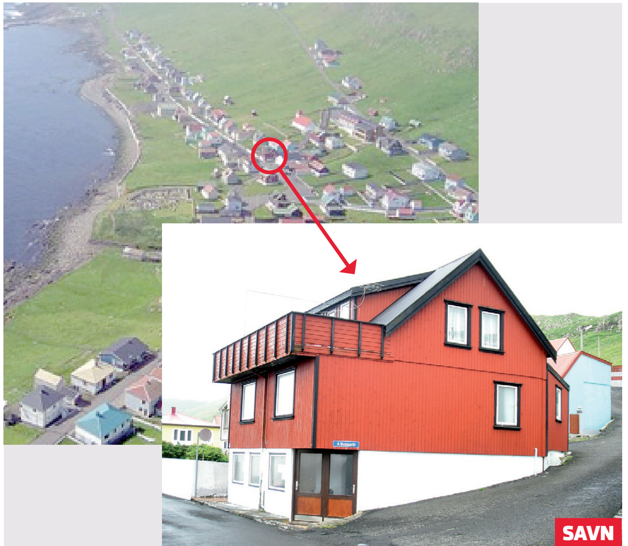
Í hesum bygninginum skal bygdarsavnið savna allar forngripirnar úr Sumba
