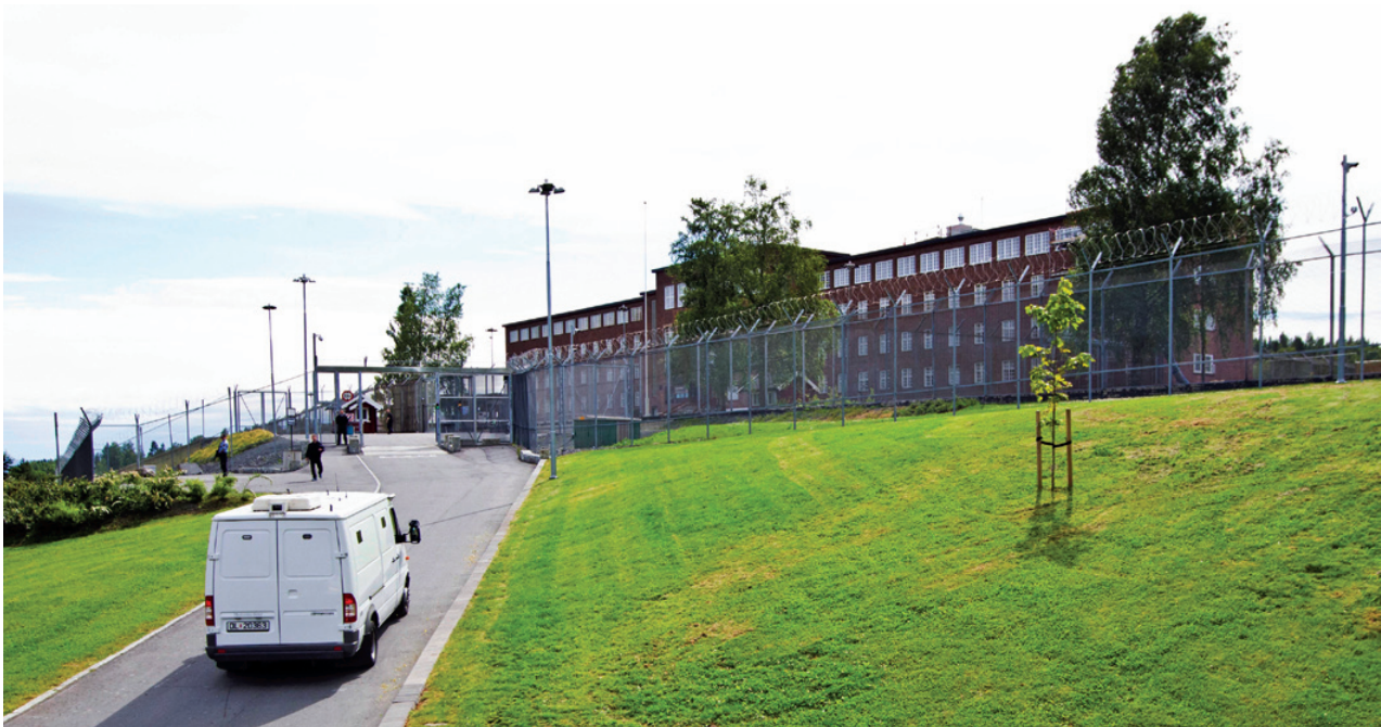
Ila-fongслиð uttan fyri Oslo skal hýsa Anders Behring Breivik
