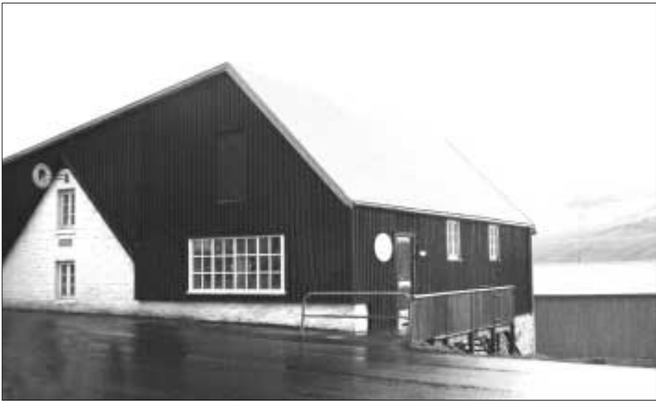
Í 1887 bygdi Sámál Petur Petersen av Miðgerði í Kollafirði hendan handilin, sum stendur miðskeiðis í Fuglafirði. Handilsvirksemi gekk væl, og 1910 varð hann noyddur at byggja ein goymslubygning afturat vestan fyri handilin. Í dag eru Piddasa handil og Ribarhús karmur um list, heimavirki og skeiðvirksemi
