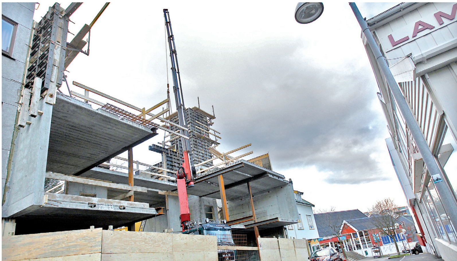
Tað gamla er skrætt niður, og arbeiðið við at byggja nýggja húsið gongur við fullari ferð
