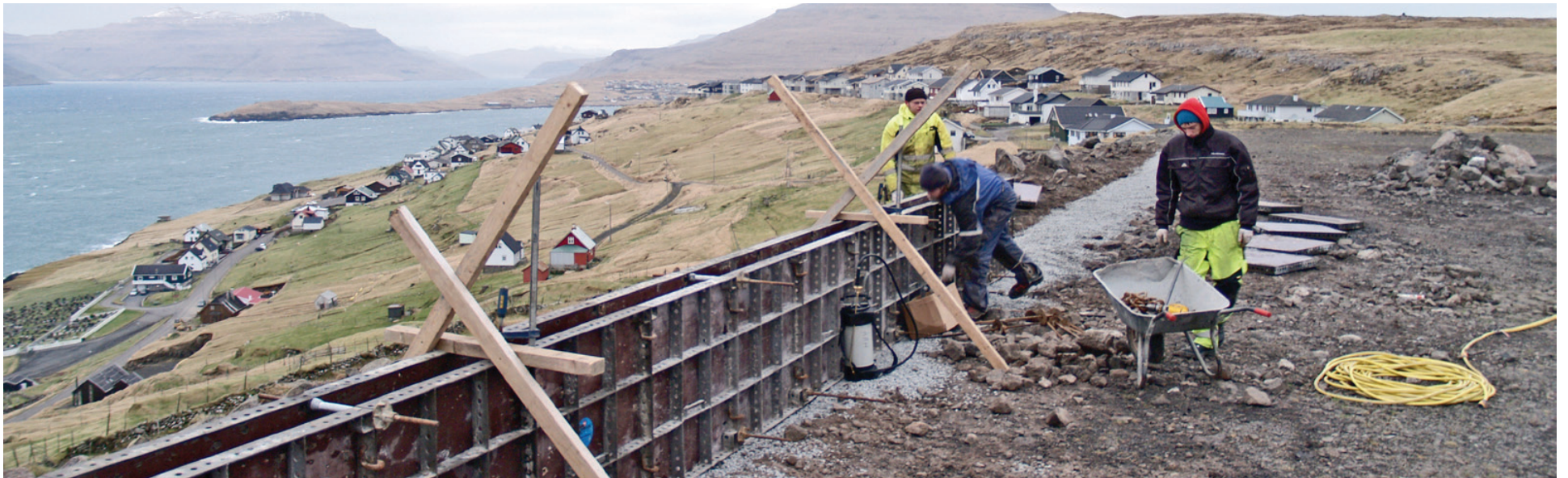
Menn frá byggivirkinum KBH eru í gongd við at seta formarnar upp á grundstykkinum á Nesi
