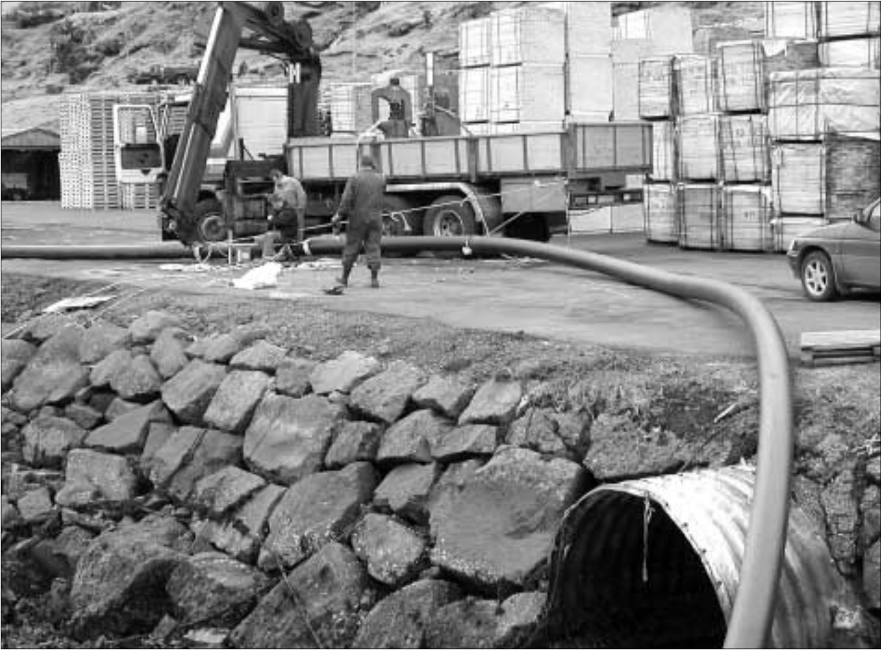
Menn frá Fiskaaling saman við fólki eitt nú frá Vónini og KJ-Hydralik hava verið í holt við at gera ein 132 metra langan søkkring á kaiøkinum í Funningsfirði. Sökkringurin bleiv gjordur úr rørum og blivu gamlir veirar nýttir sum søkk
