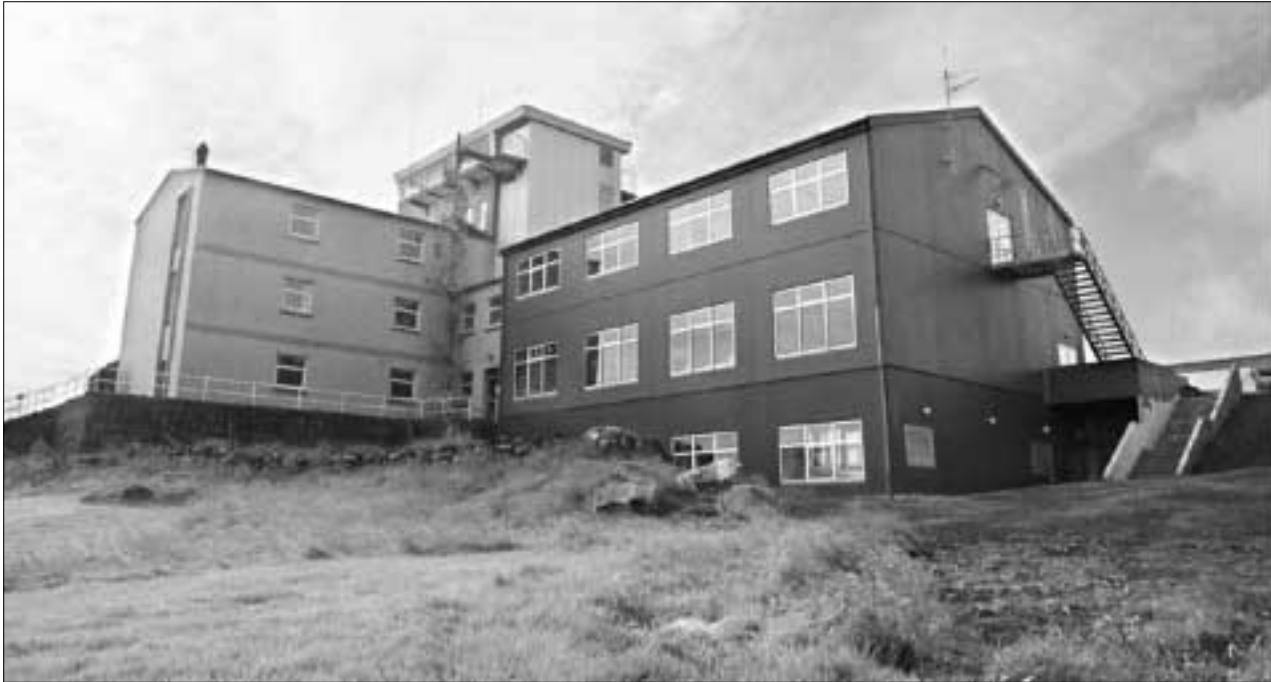
Ein háttur at loysa hølitrupulleikarnar kundi verið at bygt Sjómansskúlan út, so rúm verður fyri báðum skúlunum undir sama taki
