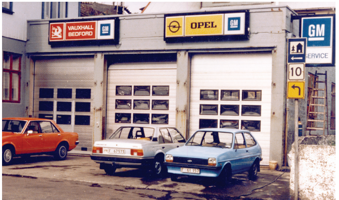
Hesin bygningurin varð tikin niður, tá bygningurin hjá Smyril Line varð bygdur á sama øki.
