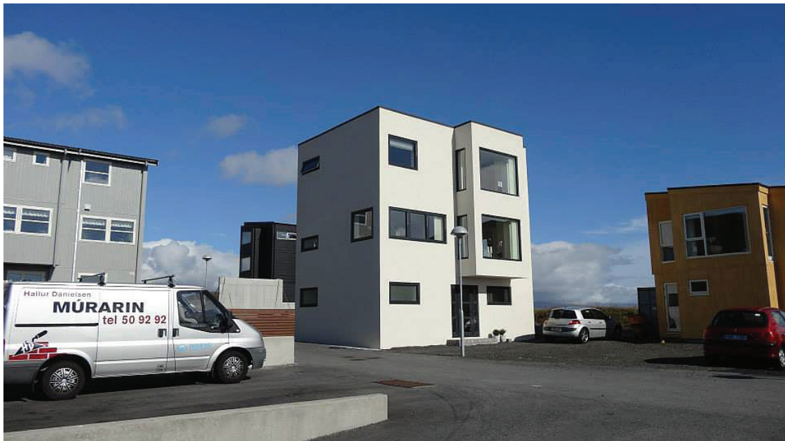
Húsini á myndini eru stoypt upp við flamingo-forskallingum, og eru soleiðis sera væl bjálvað, eins og slitsterkt litlag liggur í slutt pussinum á ytr síðuni
