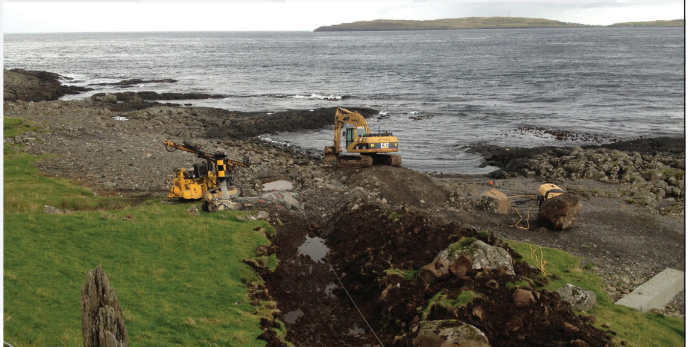
Kloakkarbeiði yviri við Strond fyrri Tórshavnar Kommunu
