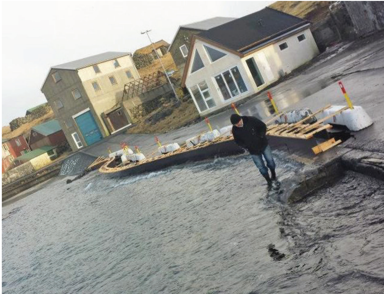
Umhvørvið á Malarenda verður hugnaligt, nú brotni bryggjukanturin er tikin burtur, og nýggjur kantur er stoyptur. Eftir er nú at taka formarnar niður aftur og leggja sand út fyri
