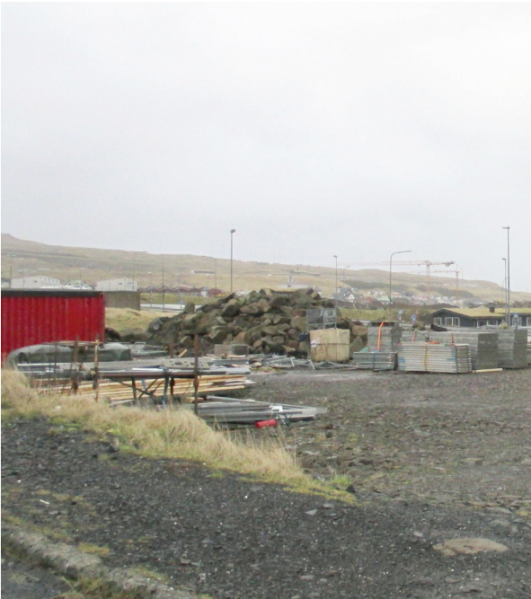
Tað er her á økinum, at Búsetur fer at byggja - og Vodafone fer at leiga
