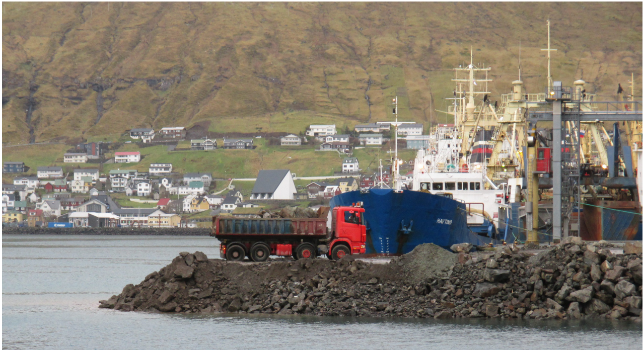
Stór útfylling fer fram við Havsbrún í Fuglafirði Mynd: Vilmund Jacobsen
