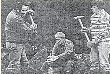
Vegarbeiði í gomlum døgum. Her skal borast hol til spreinging. Ein maður heldur borinum. Hinir skiftast um at sláa við sleggju
