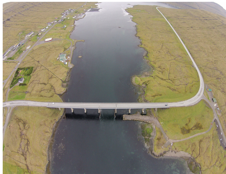
Loftmynd av økinum við Streymin, har ið náttúrulundin skal staðsetast. Myndin er tikin við dronu á flogi. Mynd: Andrias Joensen, Vestmanna
