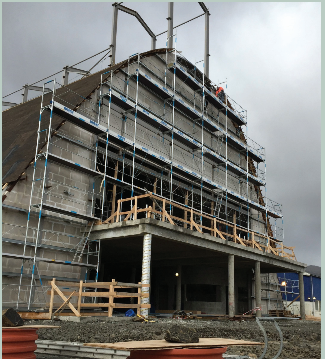
Ventilatióonsskipanin í Saltsiloini hevur sína byrjan á takloftinum, sum enn ikki er innilokað, men verður innilokað við elementum í næstum
