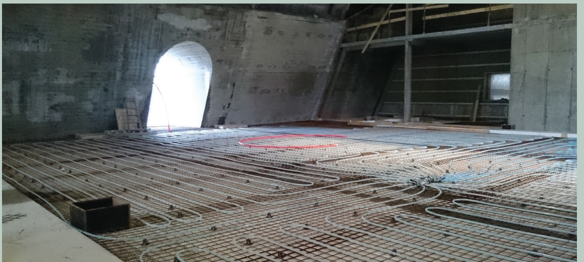
RenoVent hevur lagt umleið tríggjar kilometrar av gólvhitaslangum í Saltsiloini
