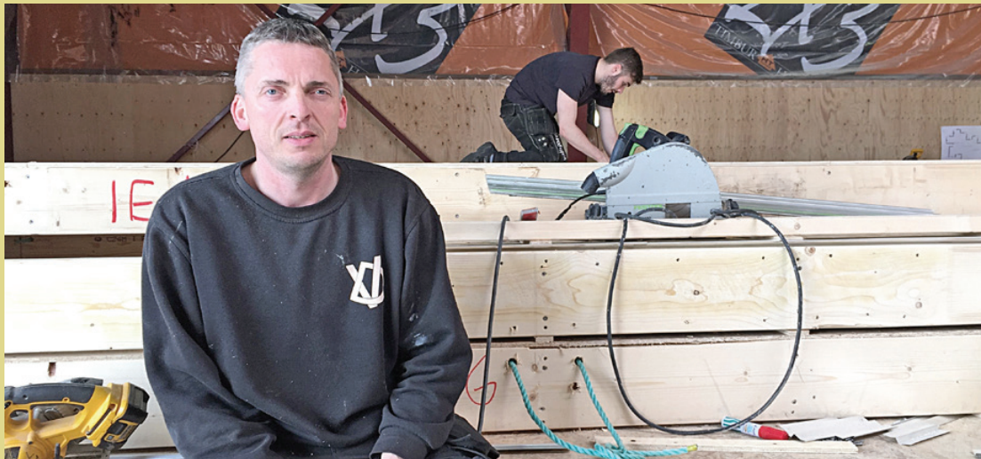
Valbjørn Dalsgarð, ið eigur og rekur byggifyritøkuna - Sp/f VD - situr her oman á nøkrum av elementunum, sum gerast partur av Virknis-og Umlættingardeplinum á Sandi
