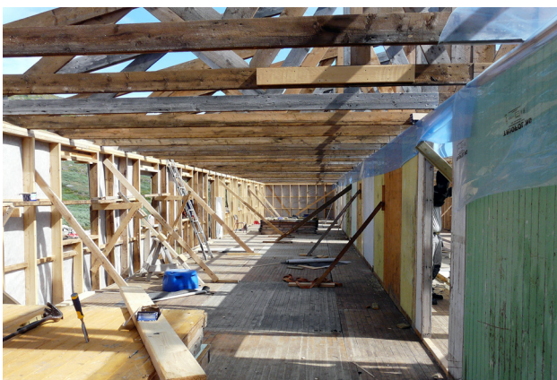
Húsini byrja at taka skap og likjast sær sjálvum. Tímrið undir vindeygum var mangastaðni so fúnað, at allir útveggir, klæðningur, vindeygu og hurðar varð gjørt úr nýggjum tilfari
