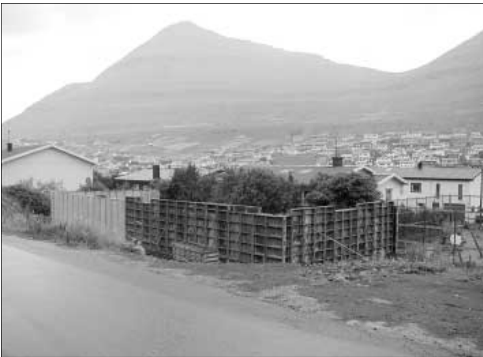
Byggingin av tvíhúsunum við Garðavegin í Klaksvík hevur ligið still síðani í mai mánaði. Og nú hevur Innlendismálaráðið ógildað byggiloyvið
