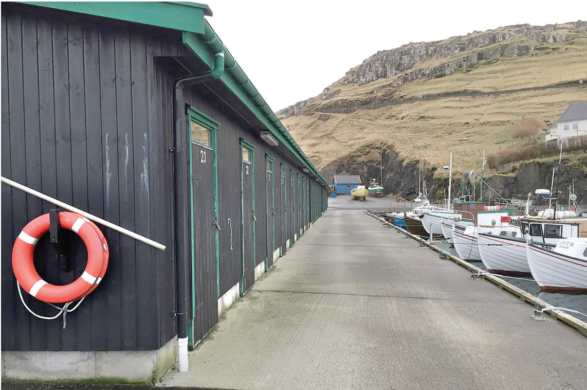
Skopunar kommuna veitir útróðrarmønnum bestu umstøður - við skúrum, krana og frysting
