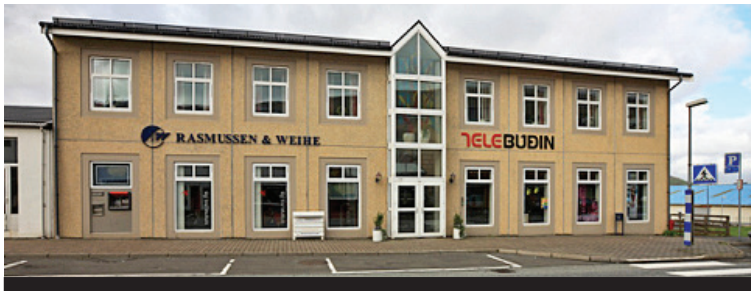
Skrivstovubygningur á Saltangará, sum Sp/f TN Bygging hevur bygt fyri felagið Snaraløkur.
